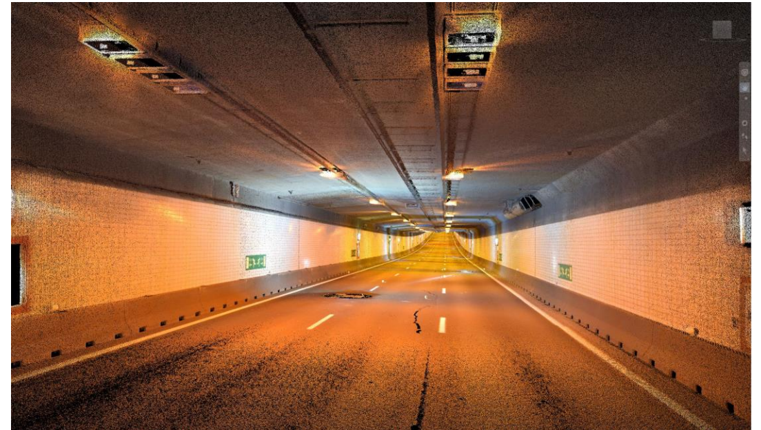
Inside the Noordtunnel, PTZ, Rijkswaterstaat
